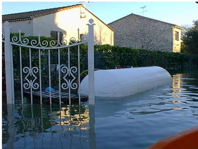
Figure 3 : Cuve de gaz flottante lors d'une inondation à Bellegarde (30) en 2003 (photo CSTB)
