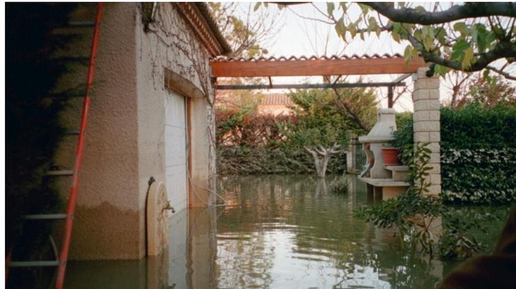
**Figure 2** : trace de remontée capillaire dans l'enduit d'un mur partiellement immergé
