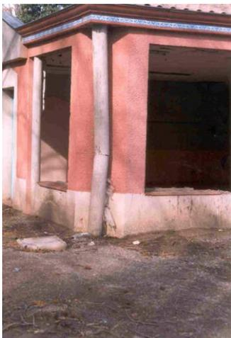
**Figure 4** : enveloppe détériorée par une vague<sup>5</sup>
